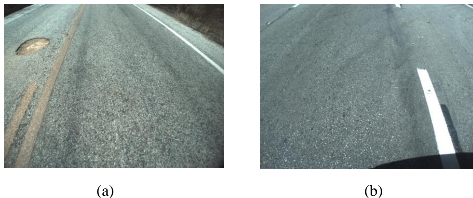
Figura 4: (a) Exemplificação de imagem com panela do dataset (b) Imagem sem defeitos do dataset .
