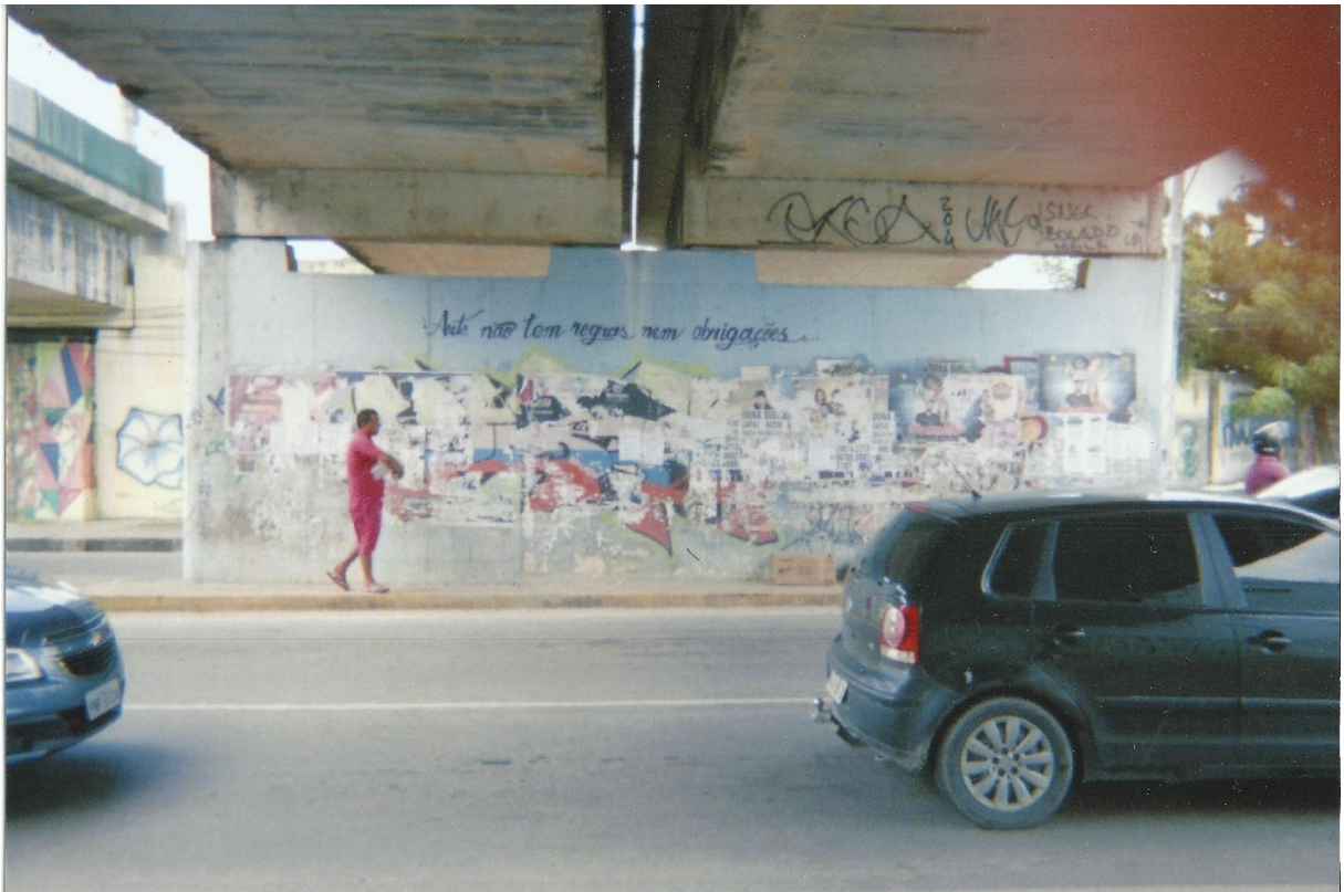
Figura 26 – Viaduto do Novo Maracanaú.
