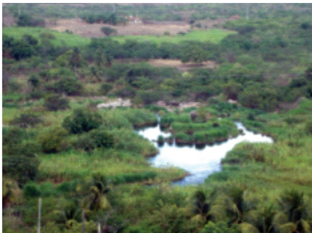
Figura 1 - Surgência de água na região de jusante
