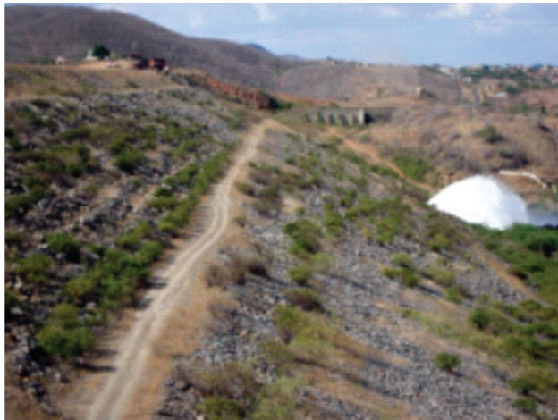
Figura 6 - Talude a Jusante
