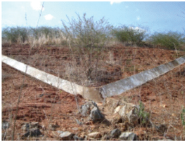
Figura 3 - Vista da região de jusante
