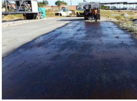
d) Aplicação da pintura de ligação
