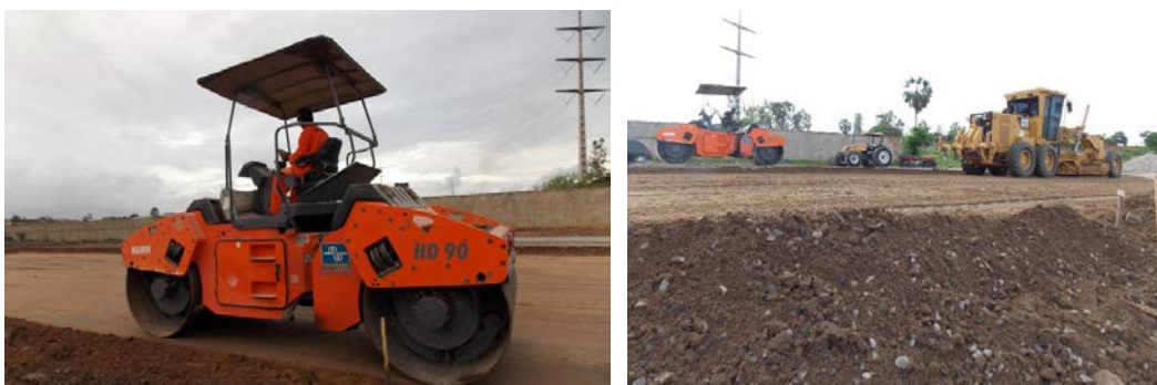
a) Compactação do subleito
