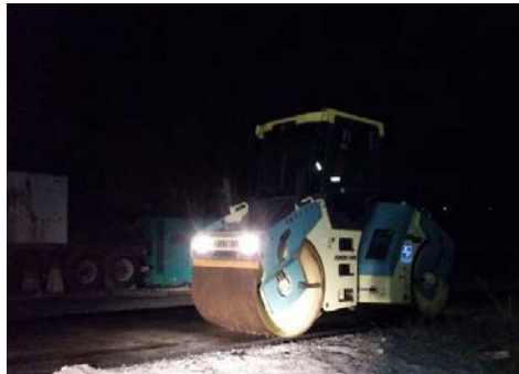
h) Compactação com rolo liso
