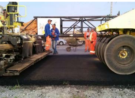
g) Compactação com rolo de pneu
