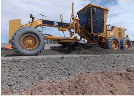
c) Construção da camada de base
