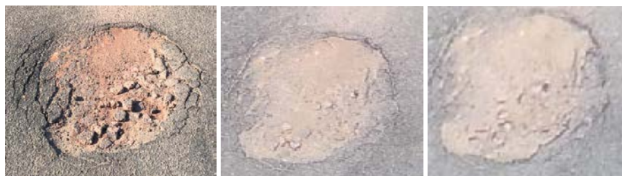
Figura 8 – Comparação das fotografias de uma mesma painela obtidas com smartphone em campo (1) e pelo UAS a 30 m de altura utilizando os métodos linear (2) e grid (3).
