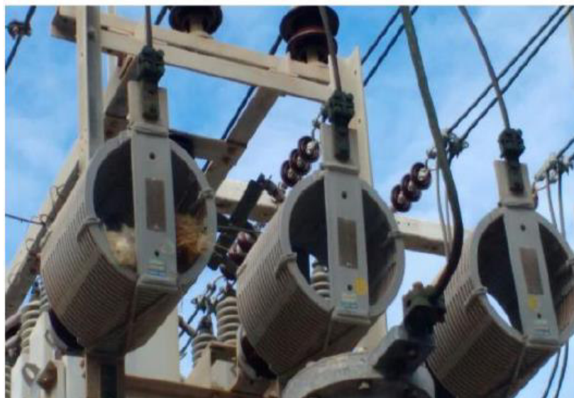
Figura 15 – Banco de Capacitor com Objeto Estranho
