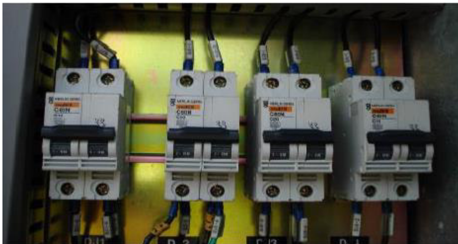
Figura 14 – Quick Lag de Disjuntor
