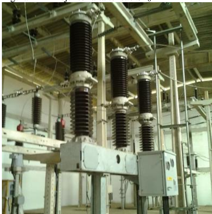
Figura 14 – Disjuntor alta tensão SF_6
