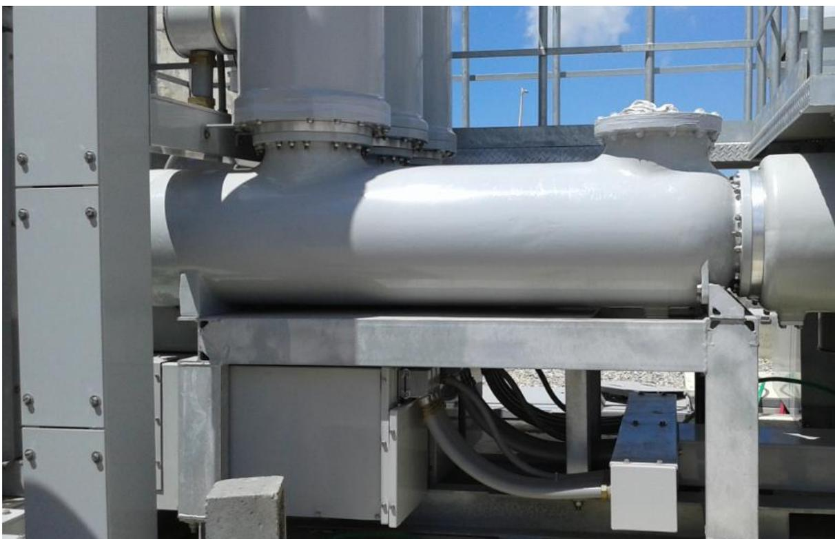
Figura 20 – Disjuntor a gás SF6 de 230 kV
