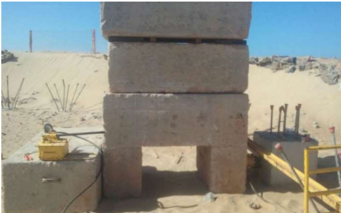
Figura 29 - Sistema de reação montado in loco
