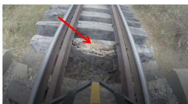
(a) Severidade 0: 1 Dormente estragado
