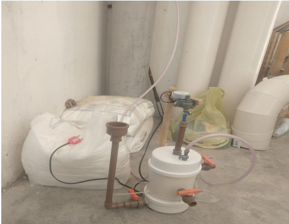
Figura 7 - Demonstração de como foi realizada a purga do sistema com gás nitrogênio.
