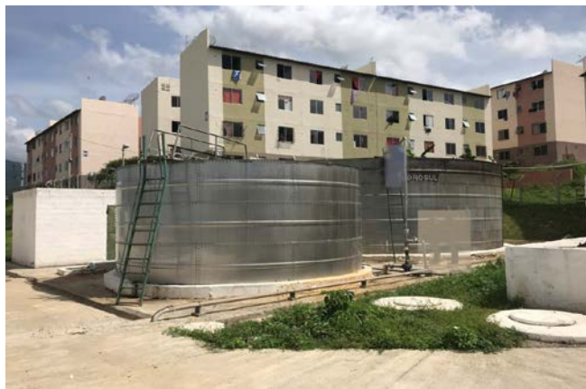
Figura 1: Estação de Tratamento de Esgotos do Residencial Nova Caiçara (Fonte: Autor, 2018).
