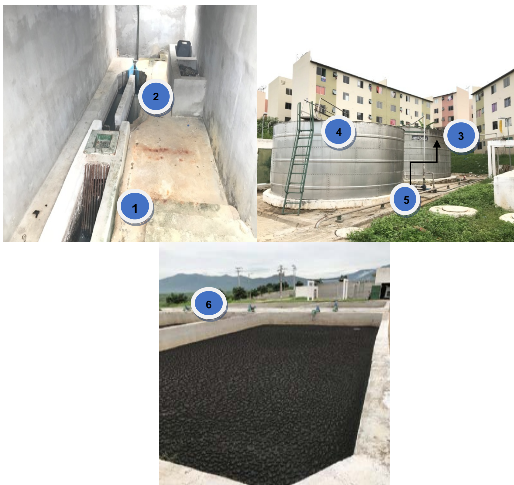
Figura 2: Unidades de tratamento componentes do sistema ETE Caiçara. Gradeamento (1); Caixa de areia (2); Tanque de aeração (3); Decantador secundário (4); Bomba de recirculação (5); Leitões de secagem (6) (Fonte: Autor, 2018).
