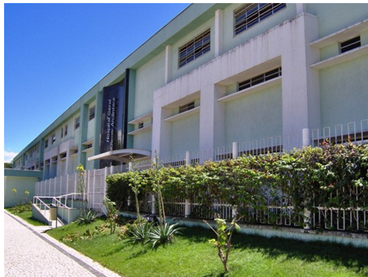
Figura 4: Entrada do hospital.
