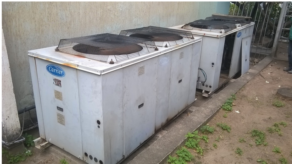
Figura 7: Unidades condensadoras.
