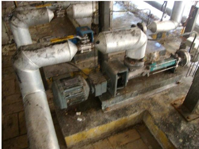
A bomba adquirida é adequada para aplicações da indústria alimentícia e farmacêutica, trabalhando com fluidos viscosos com ou sem sólidos em suspensão.
