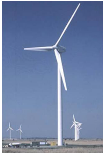
Figura 3. Gerador eólico de eixo horizontal.
