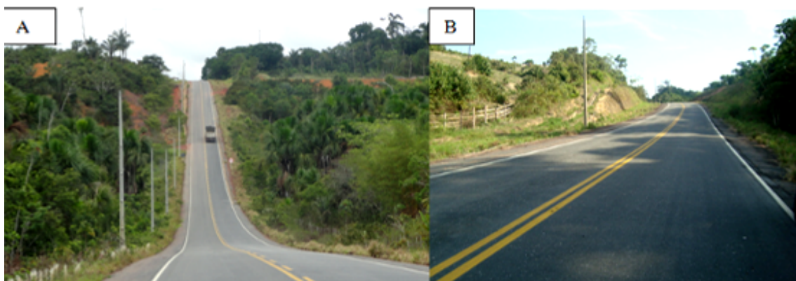
Figura 2 - Em (A) rodovia AM- 363/Itapiranga, em (B) rodovia AM-330/Silves
