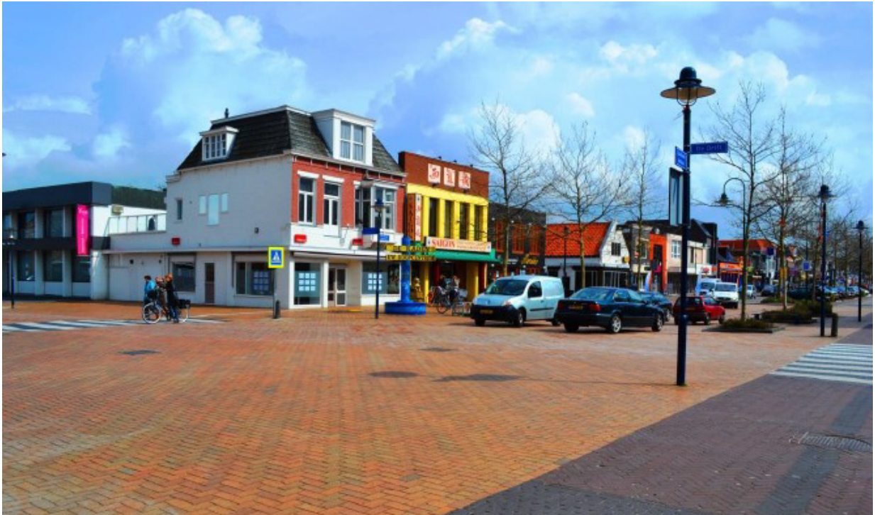
Figura 03 – Piso intertravado em vez de pavimento asfáltico – Drachten, Holanda
