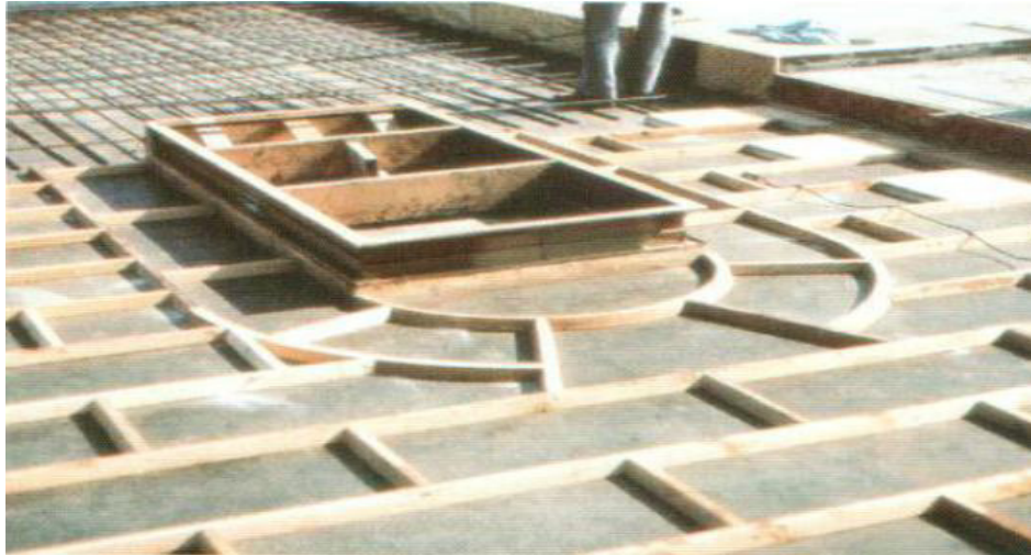
Figura 4 - Montagem das formas sobre o piso.
