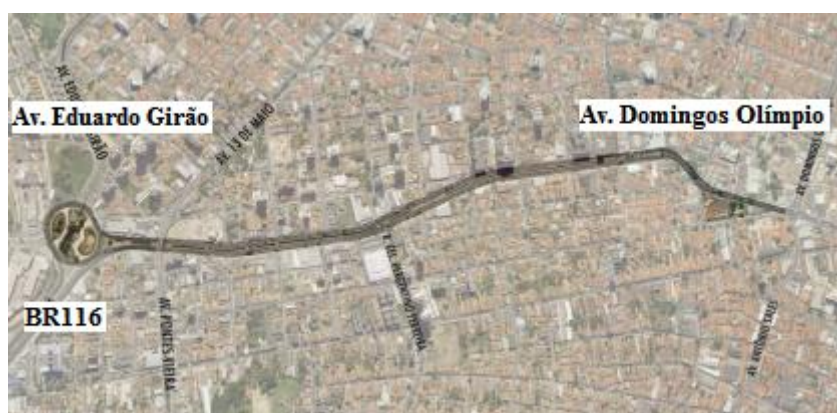
Figura 11: Obra de grande porte em Fortaleza/CE.
