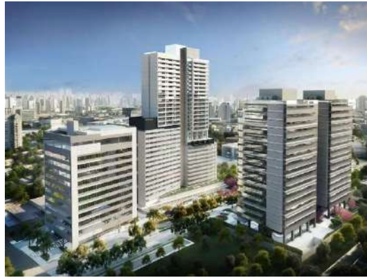
Figura 26 – Espaço entre torres
