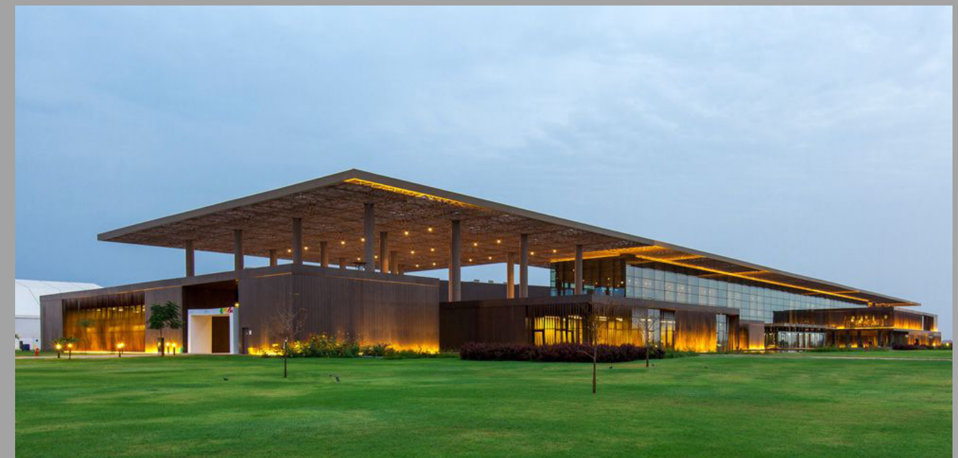
Figura 36 Centro de Convenções de Dacar. Fonte: Tabanlıoğlu Architects
