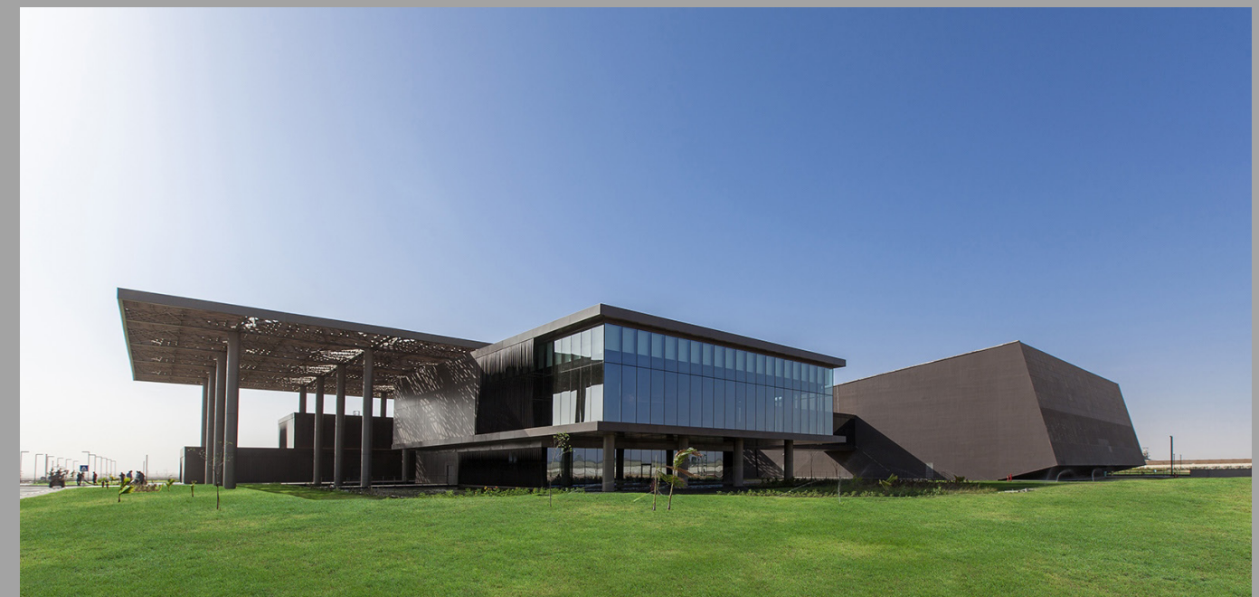
Figura 37 Centro de Convenções de Dacar. Fonte: Tabanlıoğlu Architects
