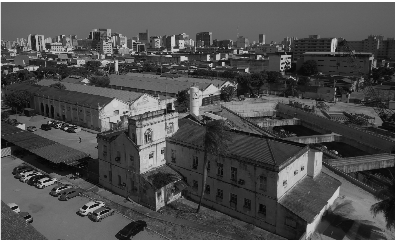
Figura 28 Construção estação de metrô. Local de implantação da Estação das Artes. Antigos galpões da RFFSA e Chalé ocupado pelo Museu Ferroviário do Ceará. Acervo pessoal.
