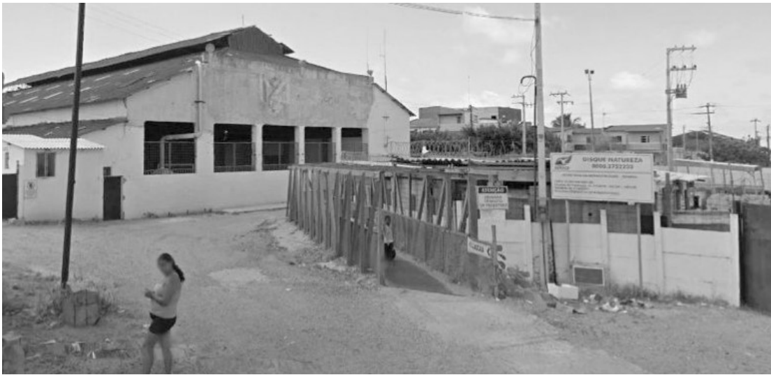
Figura 13 Passarela de acesso ao bairro Moura Brasil. Acervo pessoal.
