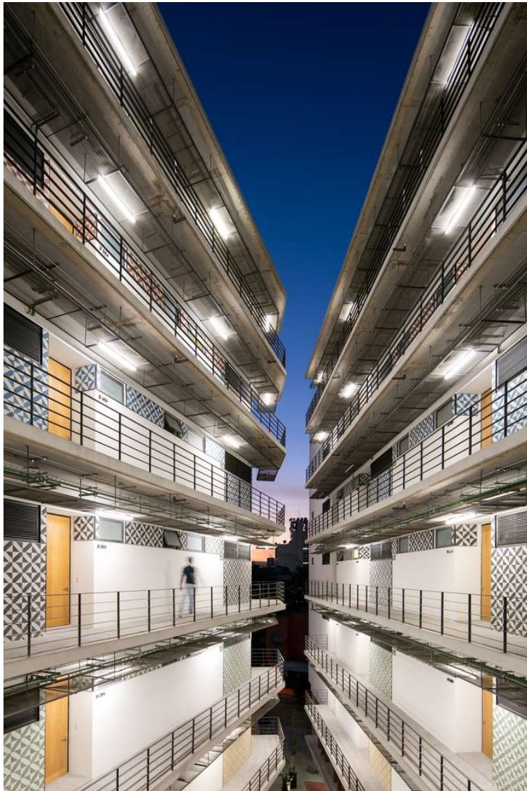
Figura 48 – Vão da circulação horizontal
