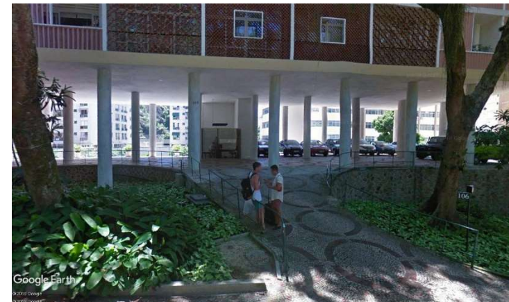
Figura 32 – Vista do acesso após reforma Fonte: Google Street View
