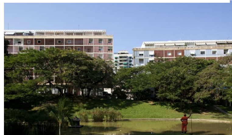
Figura 17 - Vista dos edifícios a partir do parque. Fonte: Clássicos da Arquitetura: Parque Eduardo Guinle / Lucio Costa. archdaily.com.br
