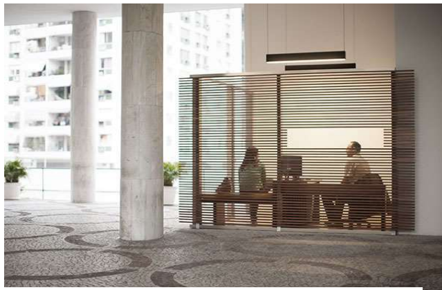
Figura 35 - Vista da guarita após a reforma. Fonte: Intervenção no Parque Guinle. grua.arq.br
