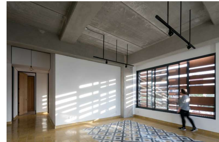
Figura 47 – Janela com vedação em painéis de brise em madeira.
