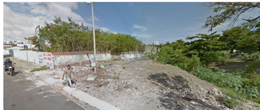
Figura 80 – Foto a partir Rua Tavares Coutinho – Início do trecho do Riacho a céu aberto é marcado por estado degradado e muros Fonte: Google Street View
