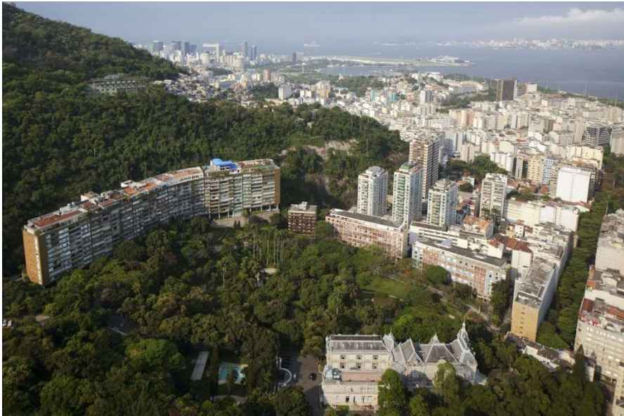
Figura 12 - Vista aérea Parque Eduardo Guinle. Fonte: Clássicos da Arquitetura: Parque Eduardo Guinle / Lucio Costa. archdaily.com.br . Disponível em: https://www.archdaily.com.br/01-14549/classicos-da-arquitetura-parque-eduardo-guinle-lucio-costa
