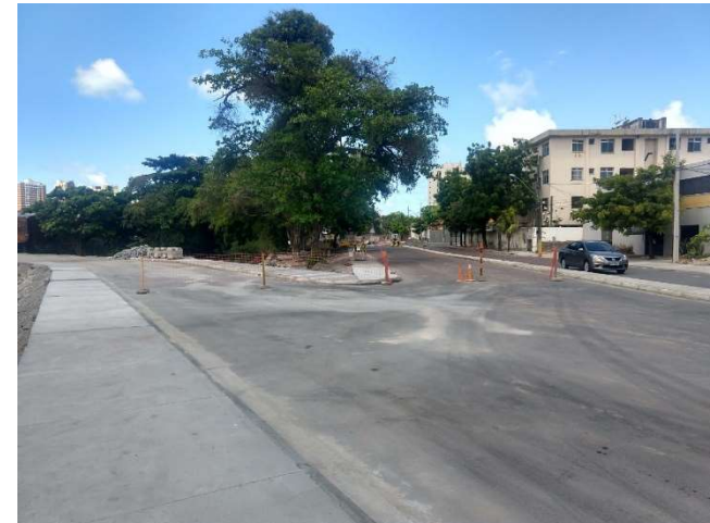
Figura 87 – Foto da rua Dr. Alísio Mamede durante a obra. A via foi duplicada, utilizando área do riacho para sua expansão. Fonte: Autor, dezembro de 2019.
