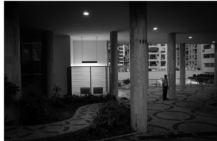
Figura 36 - Vista da guarita após a reforma. Fonte: Intervenção no Parque Guinle. grua.arq.br
