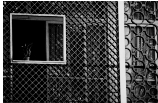
Figura 20 – Detalhe abertura central nos cobogós. Fonte: Clássicos da Arquitetura: Parque Eduardo Guinle / Lucio Costa. archdaily.com.br
