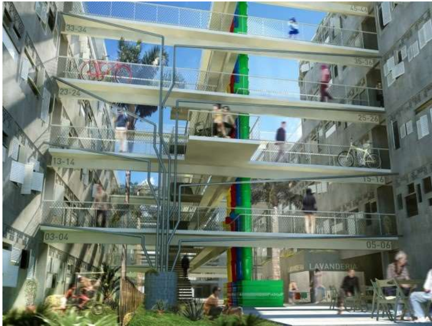
Figura 71 – Vista circulação interna com sistema de coleta de lixo coletivo e reservatório de captação de água para reuso
