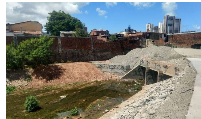
Figura 88 – Foto da obra em andamento que conecta a saída do túnel da Av. Alberto Sá com a rua Ana bilhar, passando sobre o Riacho. Localizada no início do trecho a céu aberto do riacho, é possível observar os altos muros das edificações que separam o riacho da Rua Manuel Jesuino. Fonte: Autor, dezembro de 2019.
