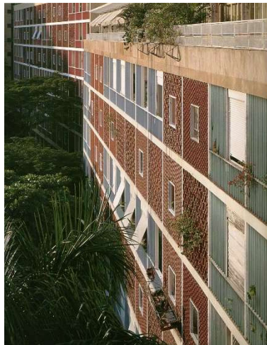
Figura 18 - Fachada com cobogós e brises . - Bristol
