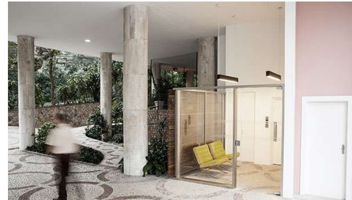
Figura 31 - Vista da guarita após reforma Fonte: Intervenção no parque Guinle. grua.arq.br . Disponível em: https://www.grua.arq.br/projetos/edificio-caledonia
