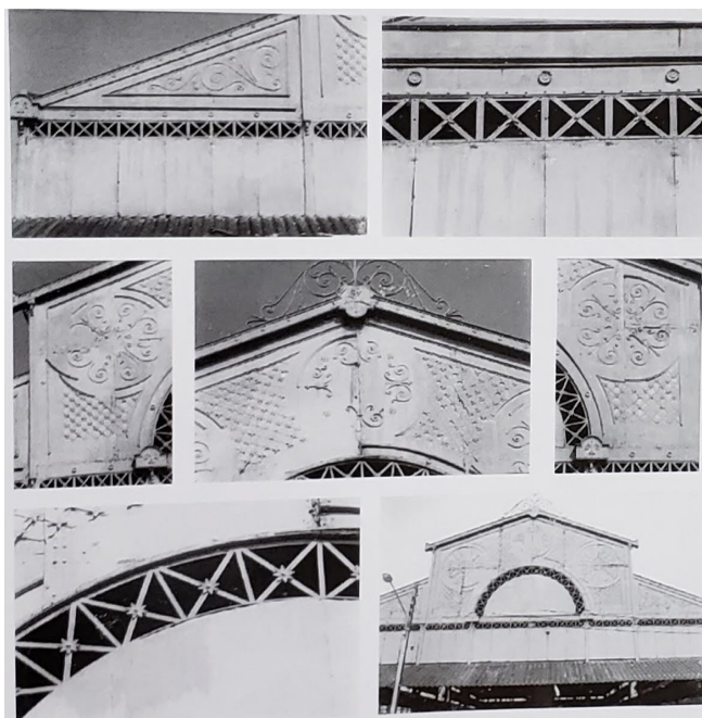
FIGURA 29 Fotos tiradas antes do processo de restauração, por Anastácia Barroso Fonte: (CAPELO FILHO; SARMIENTO, 2003)
