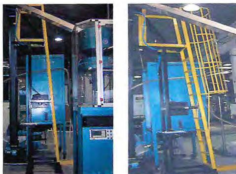
Figura 4.34 – Eliminação do risco de acidente do elevador da extrusora PMC250.
