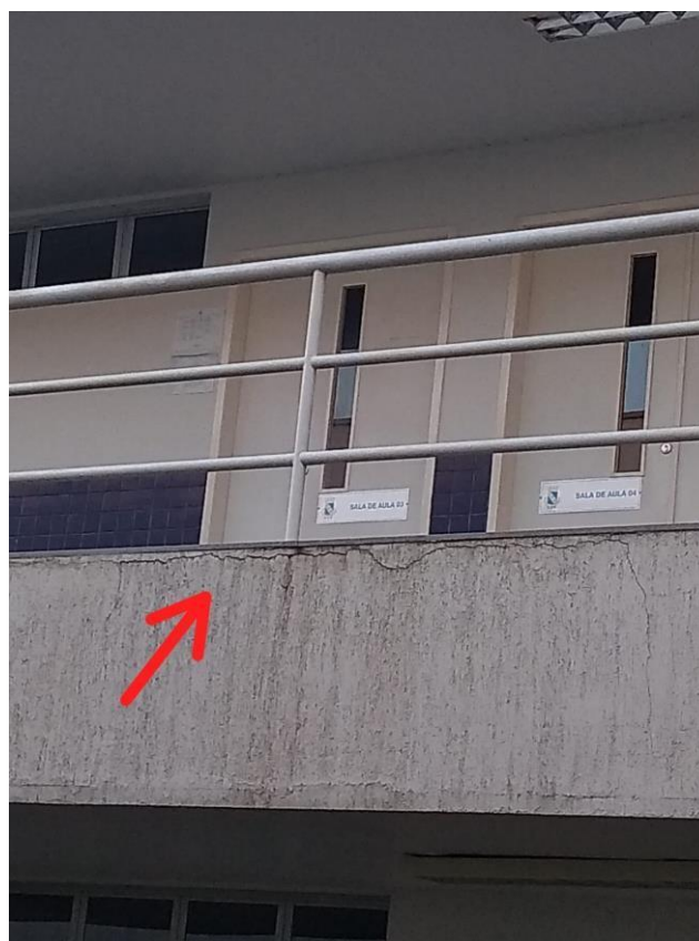
Figura 18: Fissura Higrotérmica
