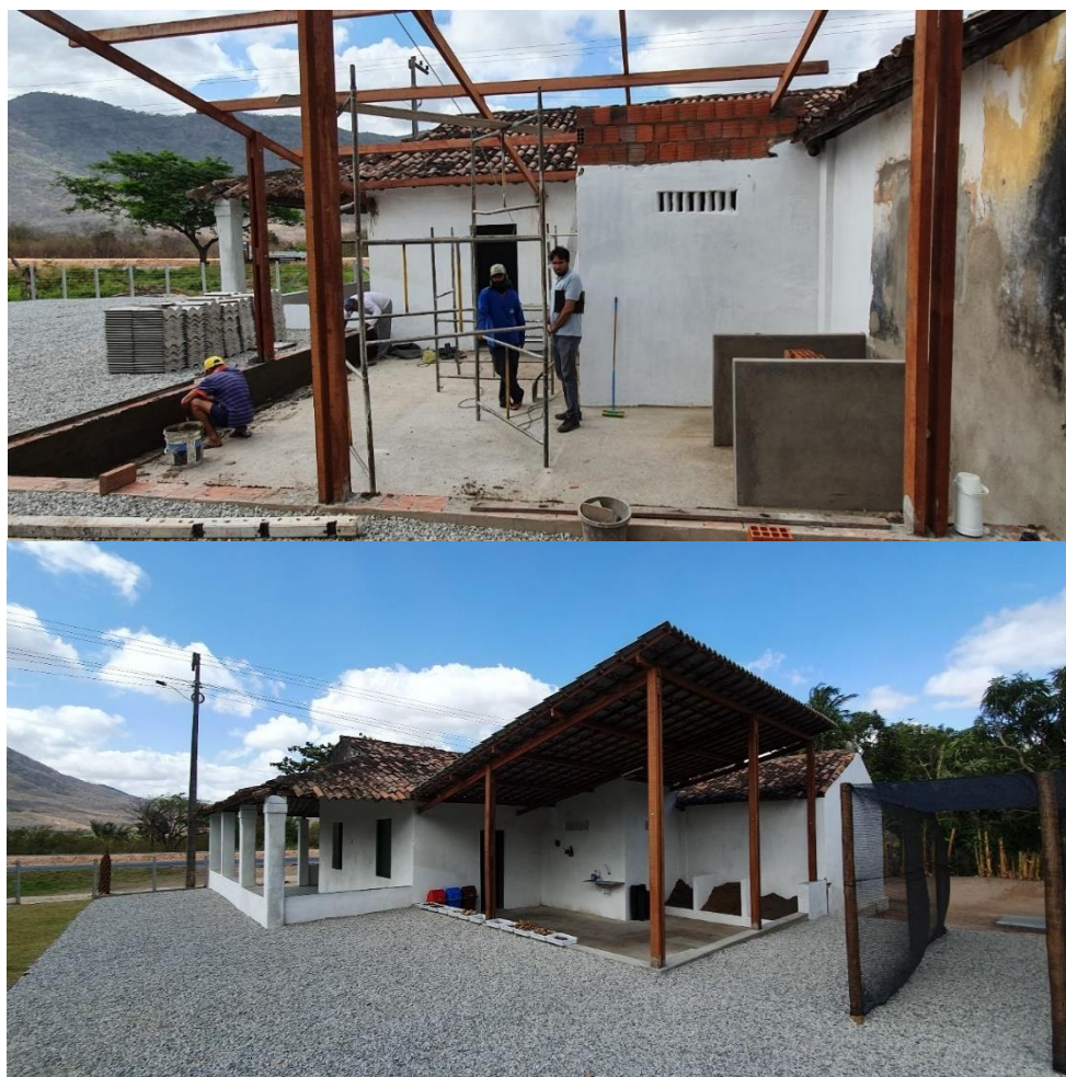
Figura 30: Acompanhamento das obras. Fonte: Própria autora (2019).
