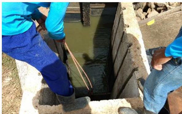
Figura 30 – Retirada das tábuas de nível.
