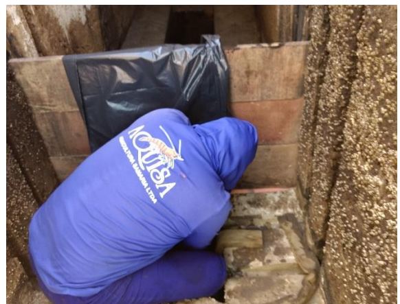
Figura 8 – Fixação e vedação das tábuas com auxílio de esponjas.
