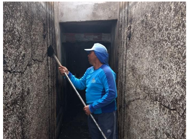
Figura 6 – Limpeza das comportas.
