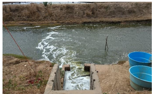
Figura 31 – Uso da água na limpeza da comporta.
