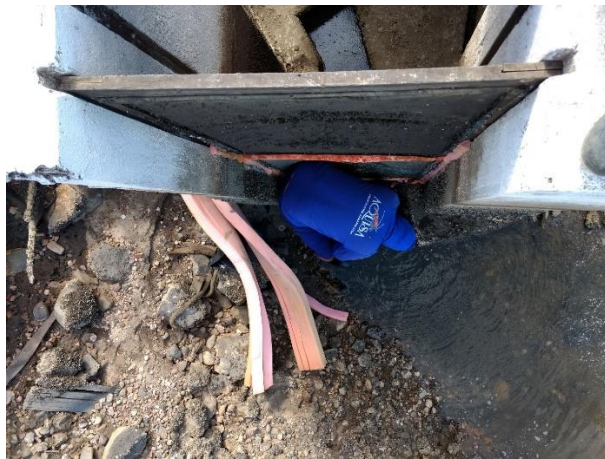
Figura 9 – Aplicação das telas de 1000 \mu\text{m} .
