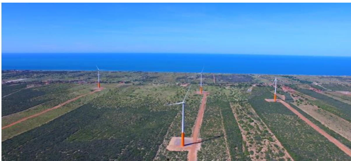
Figura 13 – Vista geral do Complexo Eólico em Icapuí/CE
