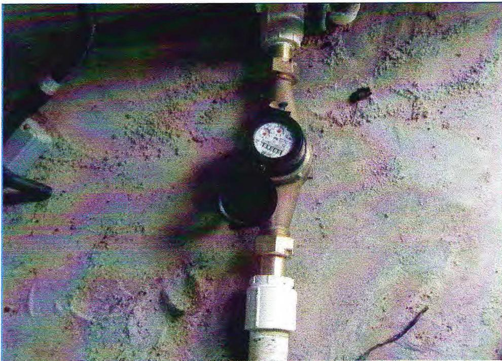
**Figura 05 – Sensor de Vazão, utilizado no poço Luísa Távora, 2005**
