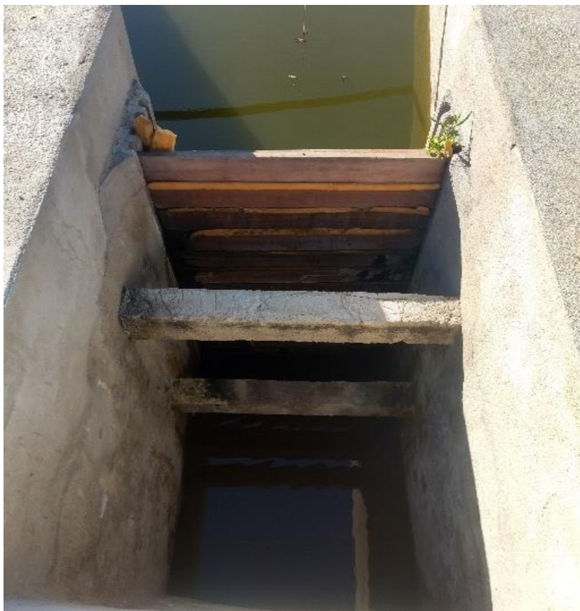
Figura 4 - Vedação entre as tábuas e ranhuras com esponjas.
