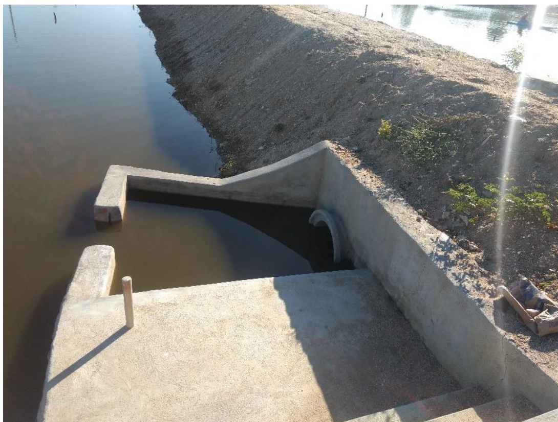
Figura 3 - Comporta de drenagem e despesca de um viveiro da Fazenda Aconcheço.
