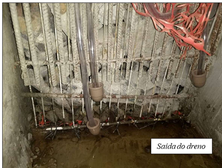
Figura 53 – Local de verificação de partículas erodidas pelo dreno
