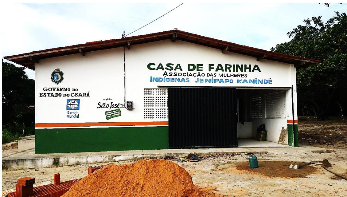
Figura 10. Reforma na casa de farinha protagonizada pela AMIJK
