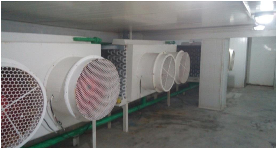
Figura 7 – Vista parcial de um dos túneis de congelamento por ar forçado.
