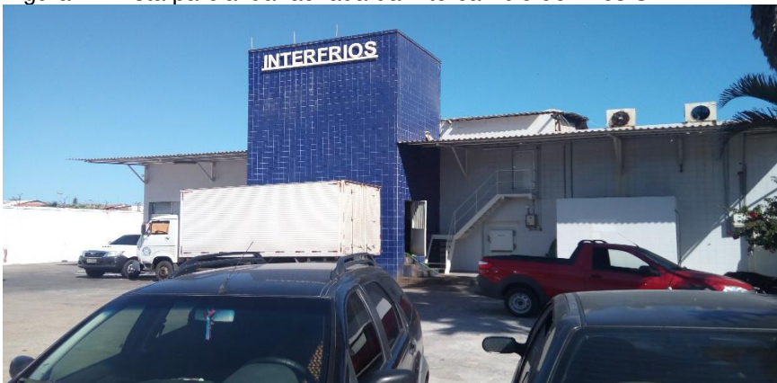
Figura 1 - Vista parcial da fachada da Intercâmbio de Frios S.A.
