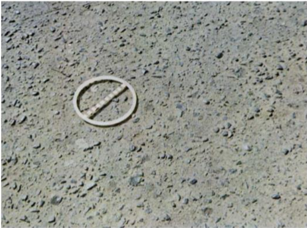
Figura 13 – Desgaste
