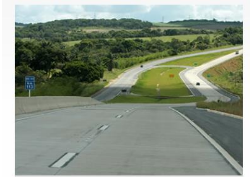
Figura 2 – Pavimento de concreto de cimento Portland
