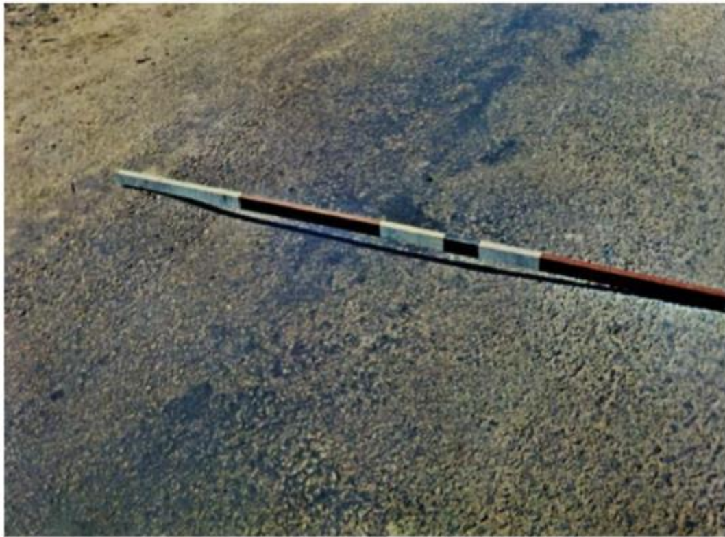
Figura 9 – Afundamento local
