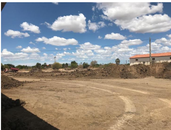
Figura 8 - Pátio de Armazenagem dos Insumos.
