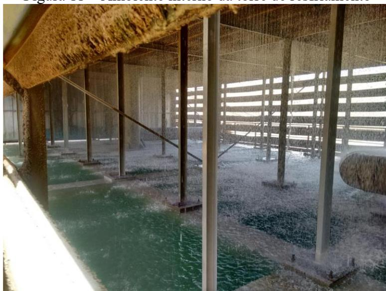
O sistema de resfriamento é composto por duas torres de resfriamento de contra fluxo acopladas em série, fabricadas pela empresa JiangSu Wei Wei Environmental Protection Technology Co., LTD. A água de resfriamento é bombeada por duas bombas e a reposição de água é feita através de uma bomba, utilizando a água da bacia hidrográfica da região. O escoamento de ar ao longo da torre é feito por convecção forçada, sendo aspirado por dois ventiladores centrífugos.
