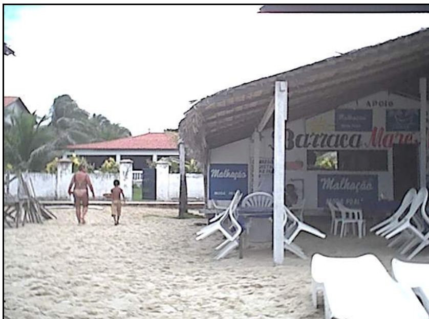
FOTO 6.1 - Ocupação da faixa litorânea, barracas de praia com precárias instalações em conflito com as residências a beira mar – Praia do Iguape. FONTE: Rosa Alice Rodrigues (2003).
