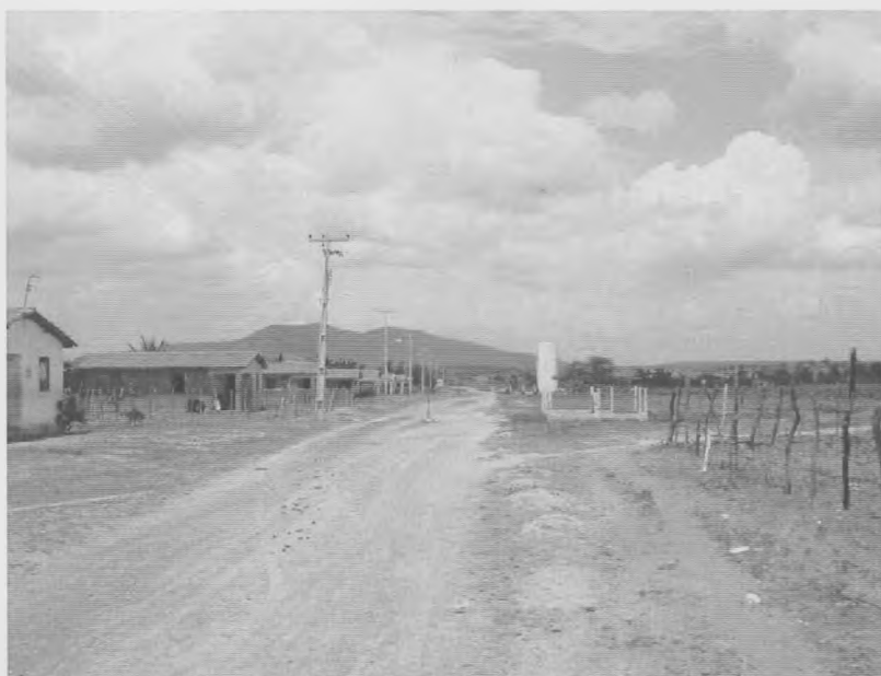
Foto 28 – Angicos, tendo à esquerda da foto a vila C, com as linhas de energia elétrica. À sua frente, parte dos dois sistemas de abastecimento de água, constando em primeiro plano um dos chafarizes do assentamento e ao fundo uma das caixas de água. Ao centro, estrada que corta todo o assentamento.
