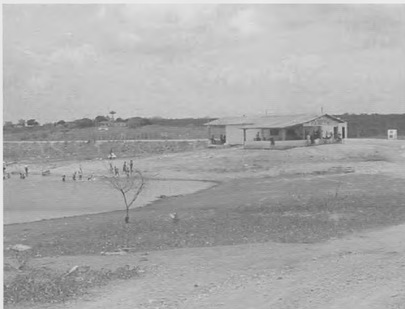
Foto 9 – Balneário do assentamento. Observa-se que as águas se afastam da parede, que está ao fundo. Árvore em primeiro plano, fica submersa quando sangria do açude.
