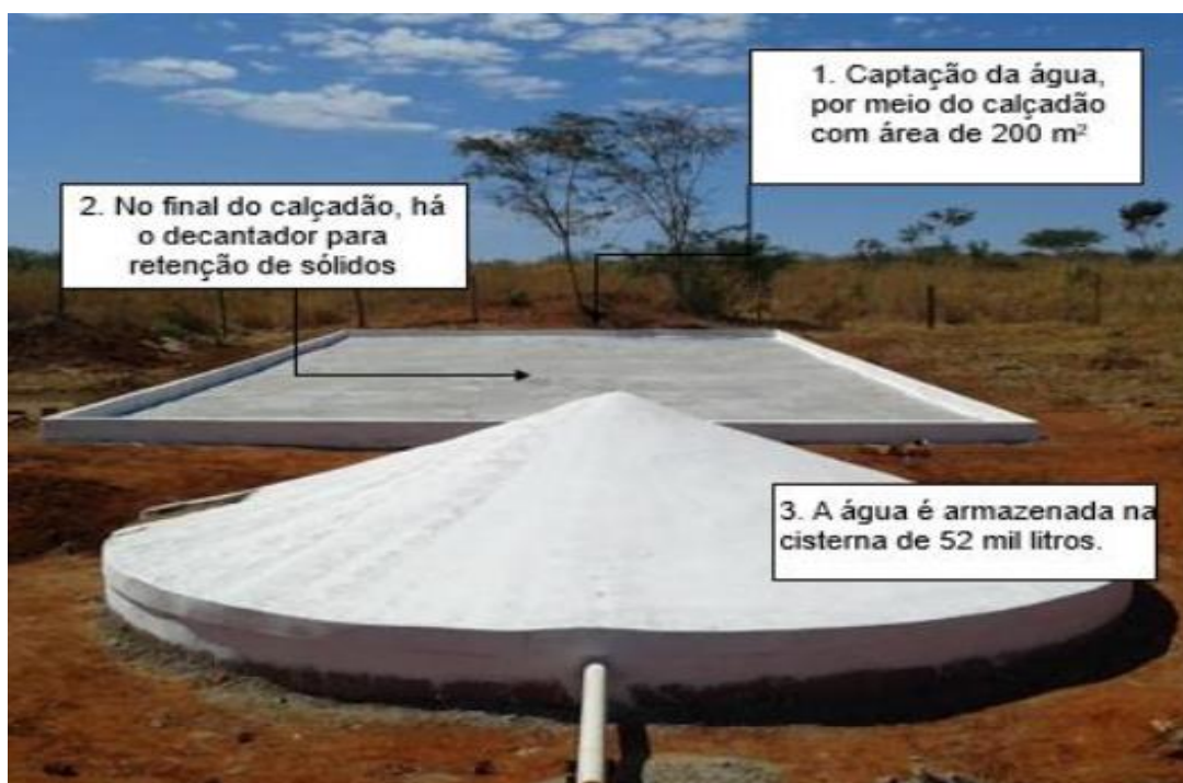
Figura 4 - Esquema da cisterna-calçada.
