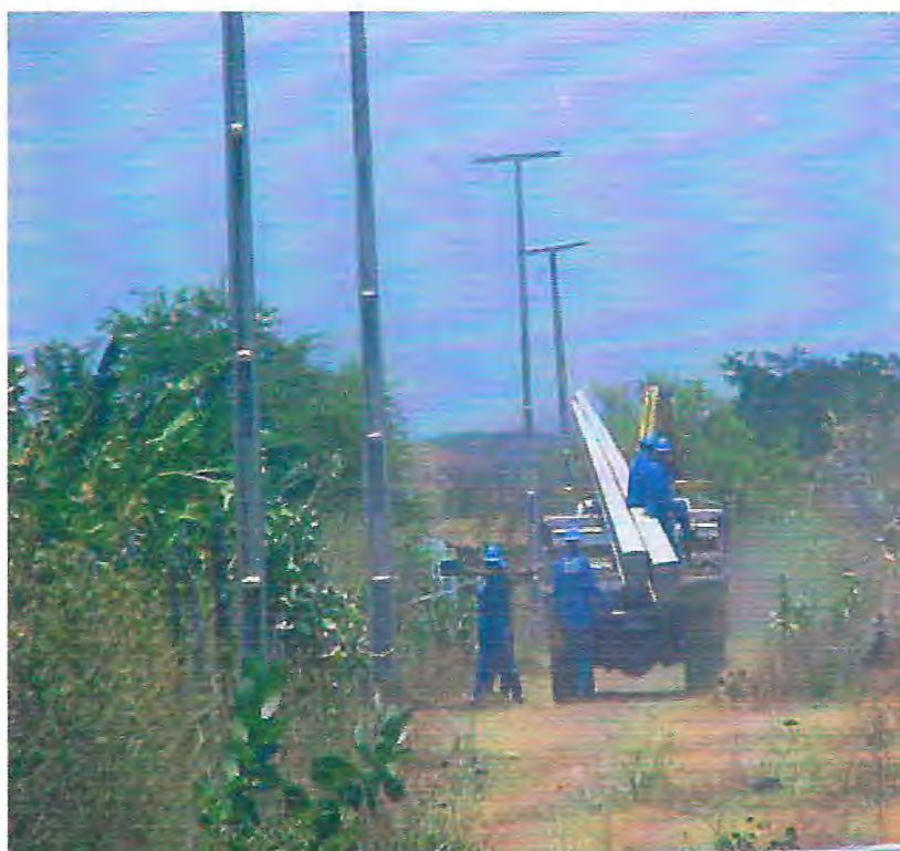
FIGURA 18 – Instalação da eletrificação nos perímetros irrigados.
