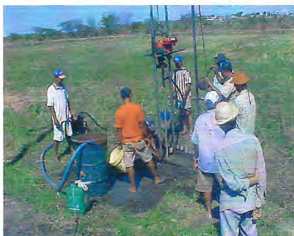
FIGURA 4 – Sondagem de poços tubulares rasos. Fonte: Equipe Técnica do Icó - 01/08/2002
