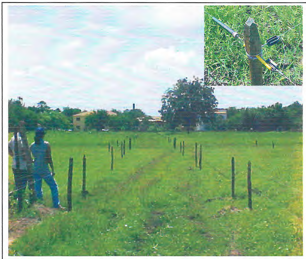
Figura 14 – Detalhes da cerca elétrica.
