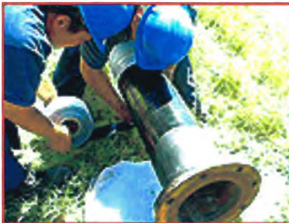
FIGURA - 2.12. Instalação de revestimento protetor.
