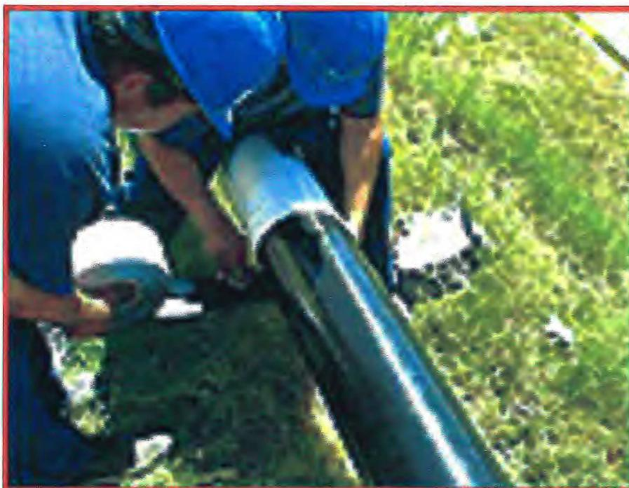
FIGURA - 2.11. Instalação de revestimento protetor.
