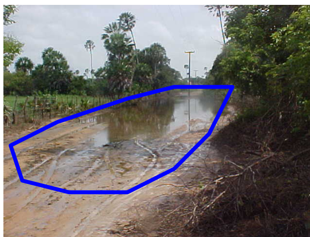
FIGURA 2.35: ESTRADA SUJEITA A ATOLEIRO
