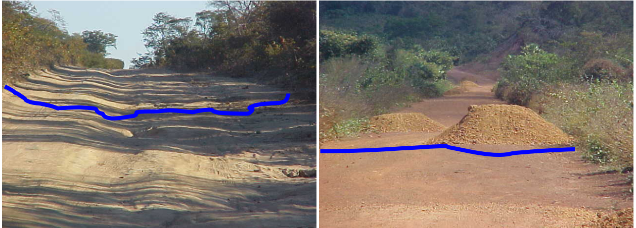
FIGURA 2.9: OCORRÊNCIA (ESQUERDA) E TENTATIVA DE CORREÇÃO DO DEFEITO STI (DIREITA)
