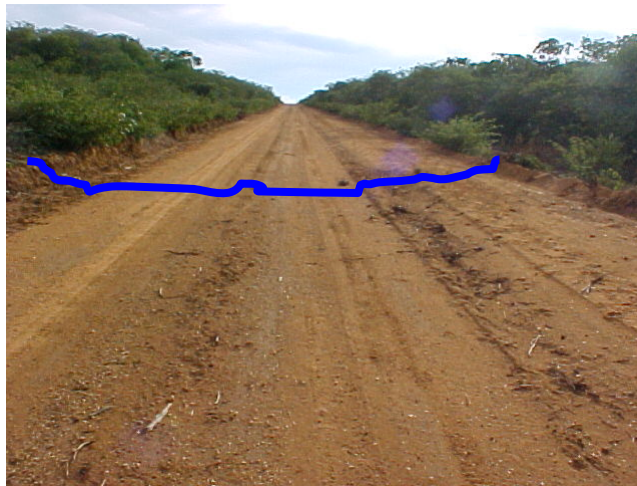
FIGURA 2.5: ESTRADA COM TRÁFEGO LOCALIZADO, FORMANDO APENAS UMA TRILHA DE RODAS
