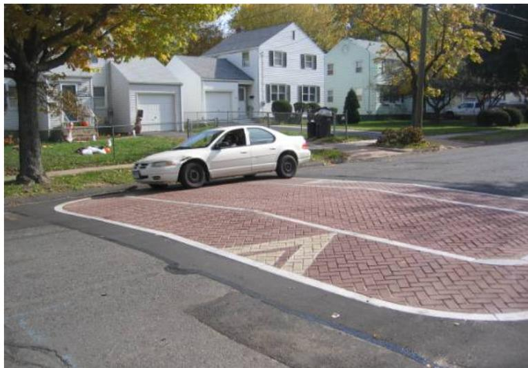
**Figura 2.25:** Mostra uma *speed table* para redução da velocidade em uma rua residencial. Fonte: [www.vtpi.org/tdm/tdm4.htm](http://www.vtpi.org/tdm/tdm4.htm)
