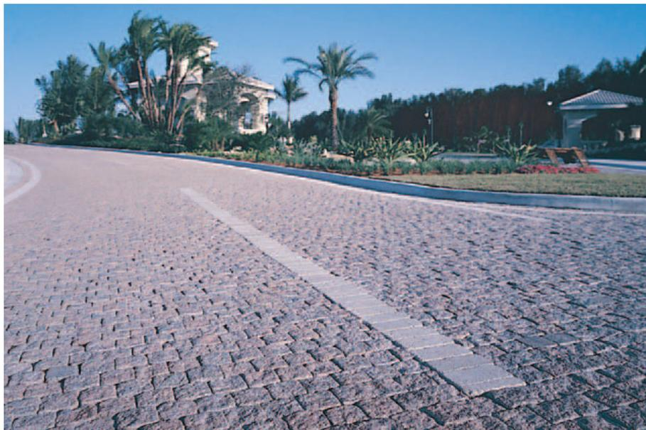
**Figura 2.9:** Blocos de pedras talhadas em paralelepípedo, Flórida, Estados Unidos. Fonte: *Interlocking Concrete Pavement Magazine* - Maio 2002
