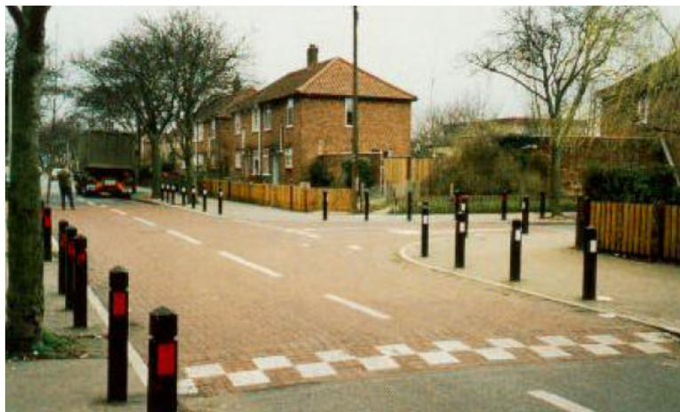
**Figura 2.22:** Interseção elevada em blocos de concreto, destacando a rampa de acesso e os balizadores na calçada. Fonte: (HASS-KLAU *et al.*,1992).
