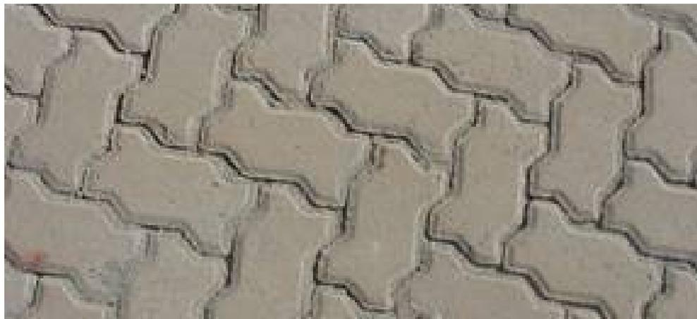
**Figura 2.10:** Arranjo no intertravamento dos blocos do tipo espinha de peixe
