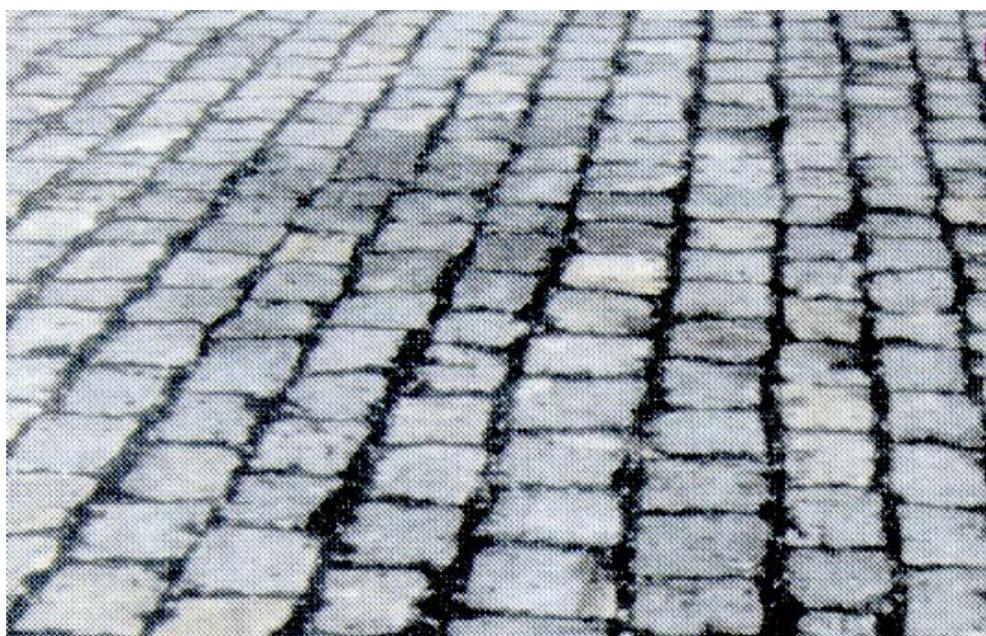
**Figura 2.13:** Pavimento BRIPAR, associa-se brita seca graduada ao paralelepípedo, rejuntado com emulsão asfáltica. Fonte: DANTAS (1992)
