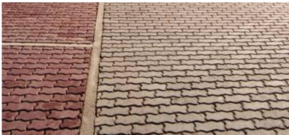
**Figura 2.11:** Arranjo no intertravamento dos blocos do tipo fileira ao corredor, em Santa Cruz, RJ. Fonte: [www.abcp.org.br](http://www.abcp.org.br)
