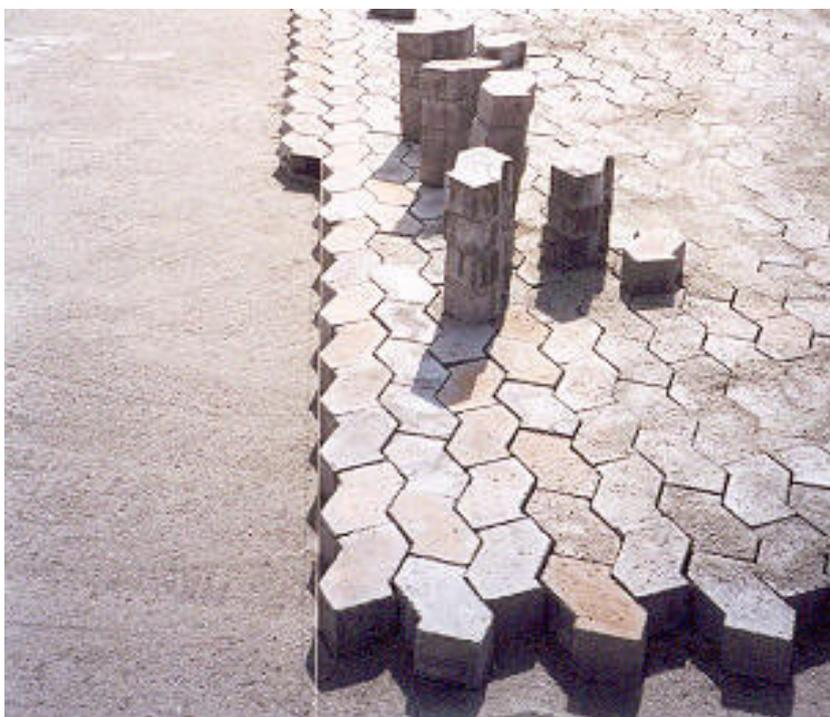
**Figura 2.16:** Execução do pavimento intertravado com blocos pré-moldados em concreto, Cais do porto, Paranaguá, PR. Fonte: ABCP
