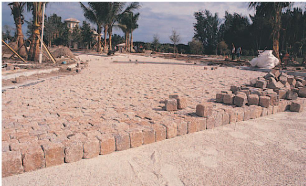
**Figura 2.15:** Execução em paralelepípedo na Flórida, Estados Unidos. Fonte: *Interlocking Concrete Pavement Magazine* - Maio 2002
