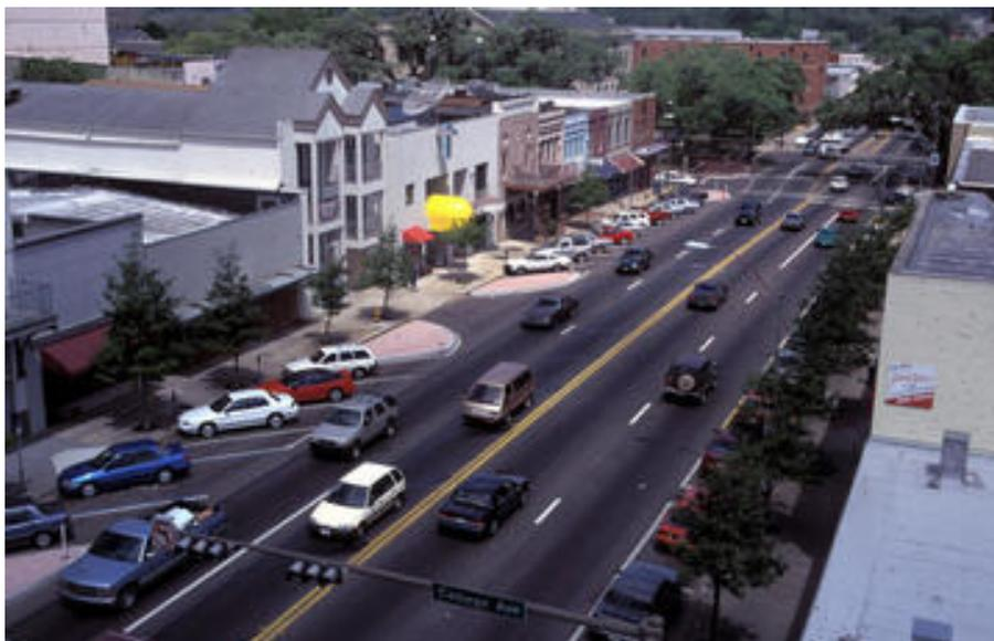
**Figura 2.26:** Estacionamento na diagonal. Fonte: [www.trafficcalming.org](http://www.trafficcalming.org)
