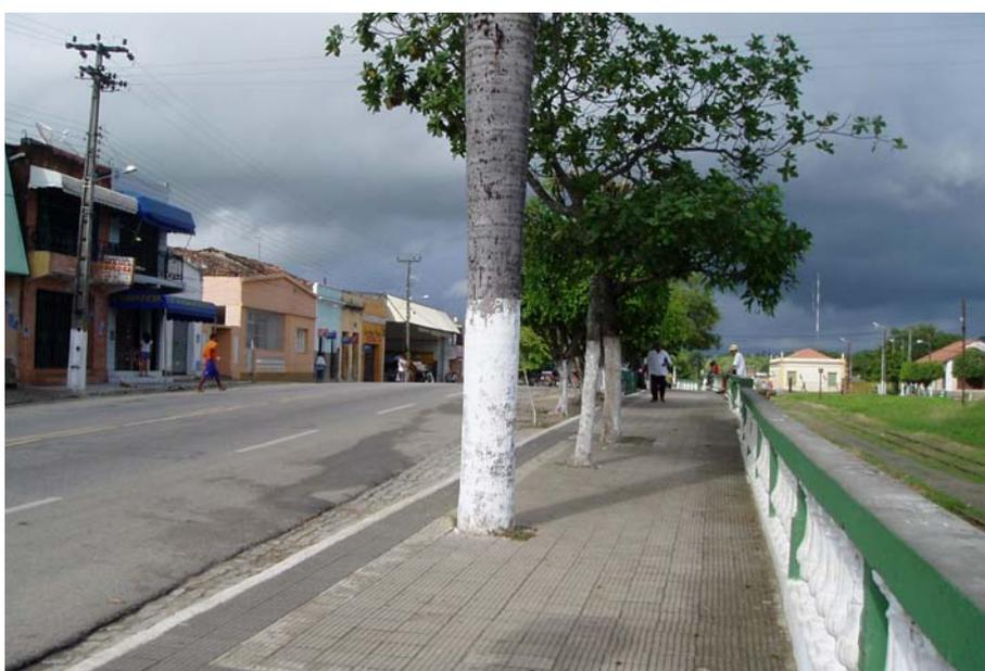
**Figura 5.11:** O nível das calçadas está abaixo do greide da rodovia. Nessas calçadas, o desnível com o greide da rodovia atinge, em alguns pontos, 30cm
