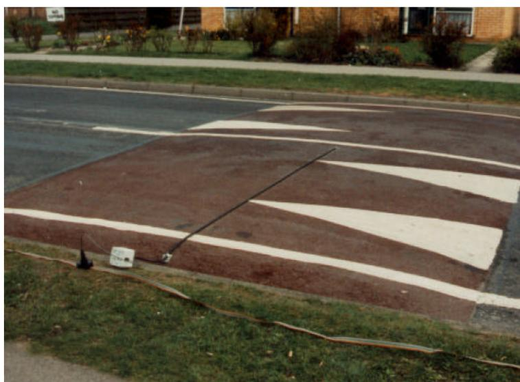
**Figura 2.21:** Lombada construída em material asfáltico na cor avermelhada
