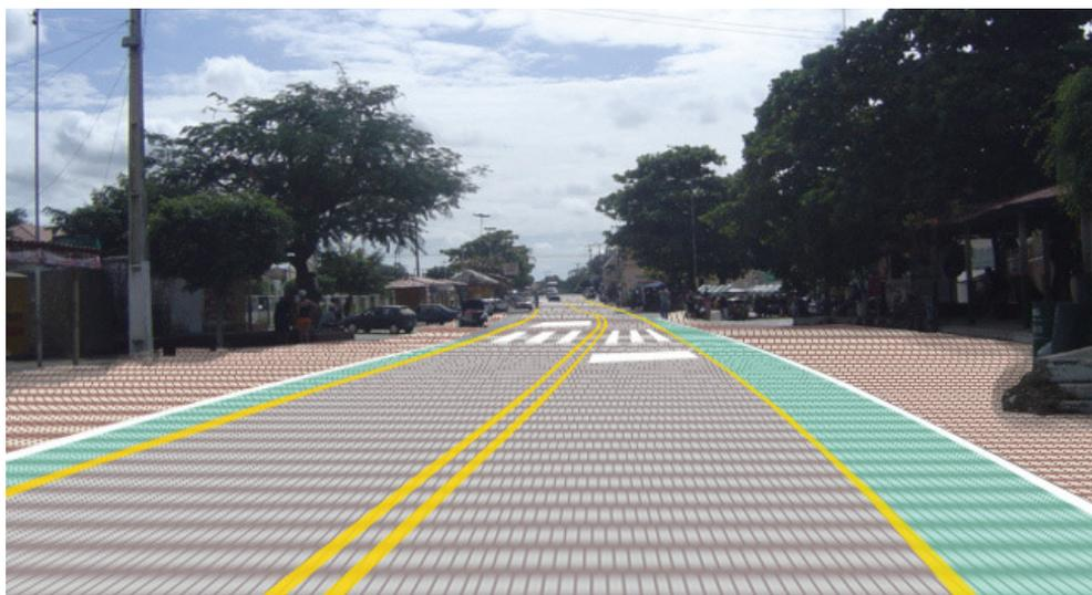
**Figura 3.10:** Travessia de Guaiúba, em pavimento intertravado
