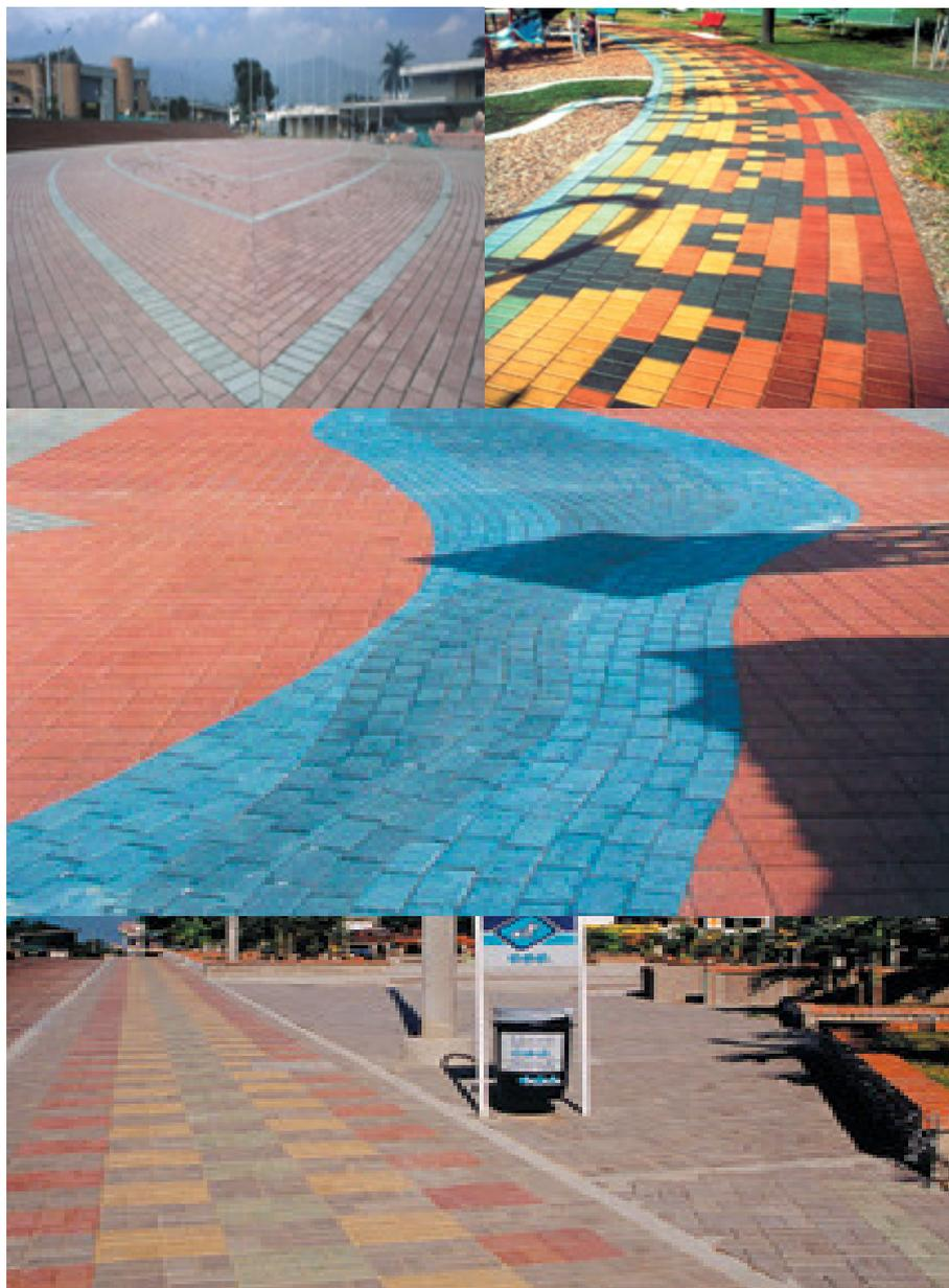
**Figura 2.18:** Vias urbanas e passeios em pavimento intertravado, as cores permitem personalizar o município. Fonte: Revista Prisma nº 10 e 12
