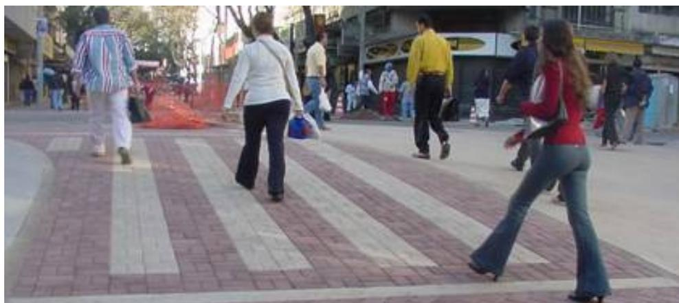
**Figura 2.12:** Formatos dos arranjos no intertravamento dos blocos do tipo trama, rua dos Caetés, em Belo Horizonte, MG. Fonte Revista Prisma Nº 9
