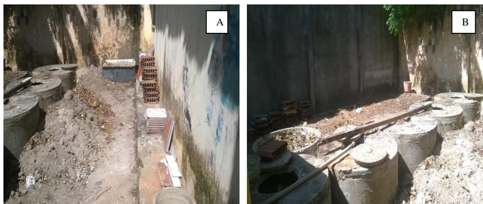
Figura 4 – Espaço destinado à implantação da horta após a limpeza.
