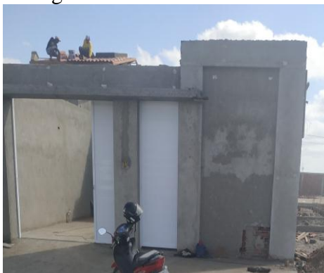
Figura 4 - Fachada da Obra A
