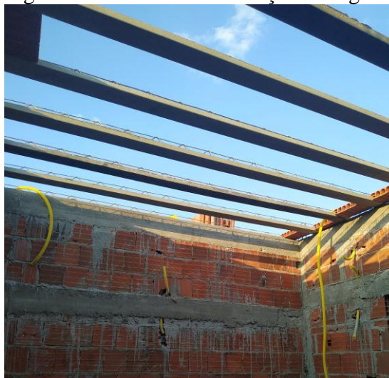
Figura 22 - Obra C: distribuição de vigotas
