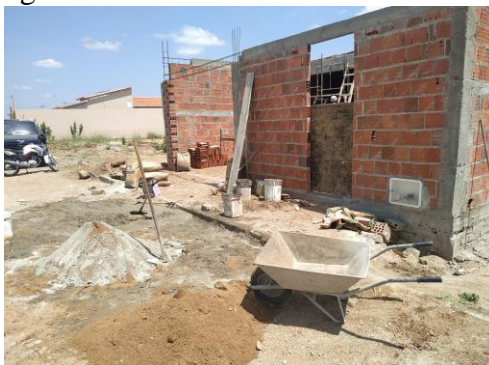
Figura 24 - Obra C: mistura do concreto
