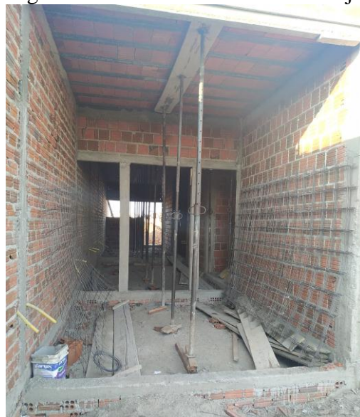
Figura 7 - Obra A: escoramento da laje
