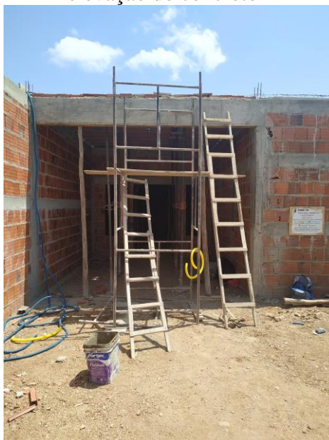
Figura 26 - Obra C: estrutura para elevação do concreto
