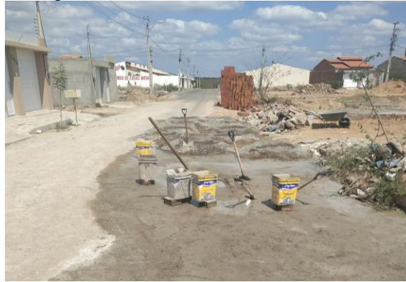
Figura 8 - Obra A: mistura do concreto
