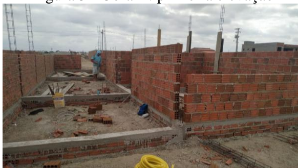
Figura 5 - Obra A: primeira elevação
