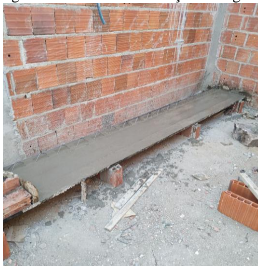
Figura 21 - Obra C: fabricação de vigotas
