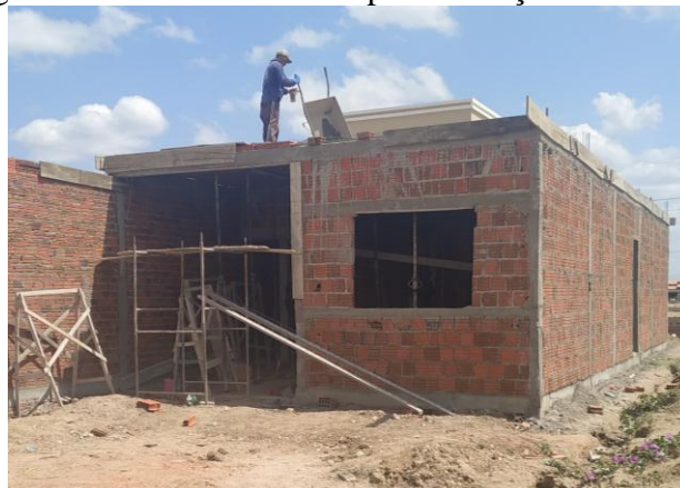
Figura 9 - Obra A: estrutura para elevação do concreto
