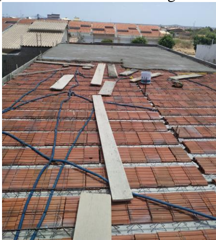
Figura 25 - Obra C: concretagem da laje
