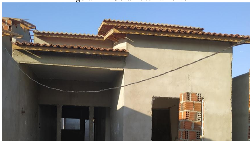
Figura 11 - Obra A: telhamento
