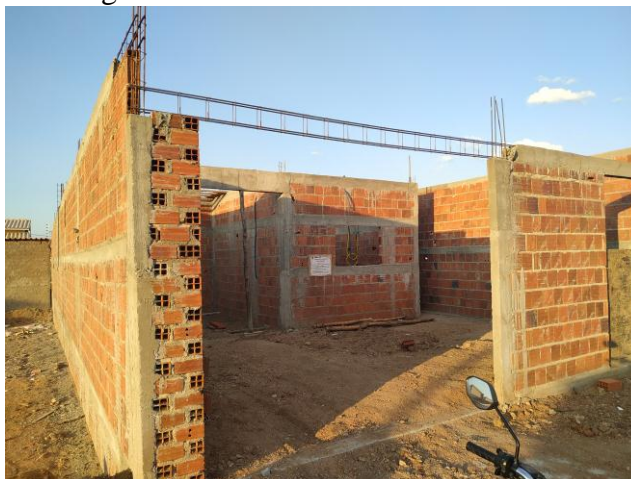
Figura 20 - Obra C no início do estudo
