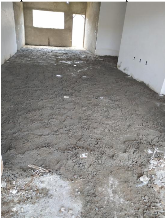
Figura 18 - Obra B: execução da primeira camada de contrapiso
