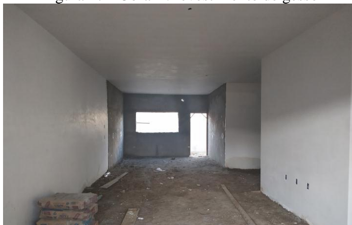
Figura 17 - Obra B: revestimento de gesso
