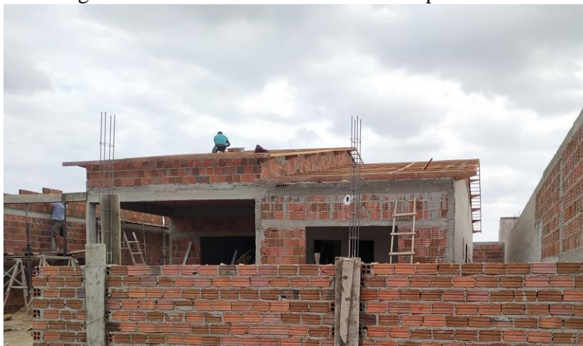
Figura 15 - Obra B: estrutura de madeira para cobertura
