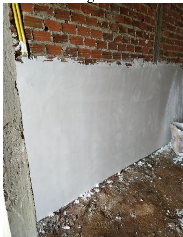
Figura 12 - Obra A: revestimento de gesso
