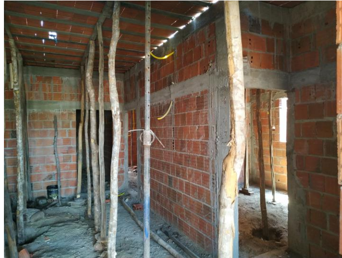
Figura 23 - Obra C: escoramento da laje
