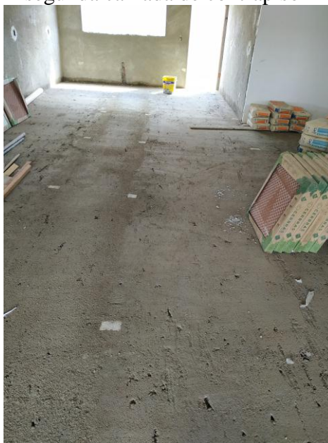
Figura 19 - Obra B: execução da segunda camada de contrapiso
