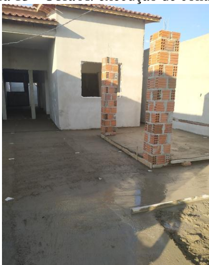
Figura 13 - Obra A: execução de contrapiso
