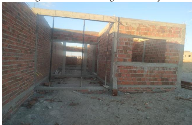
Figura 6 - Obra A: segunda elevação
