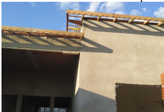
Figura 10 - Obra A: estrutura de madeira para cobertura
