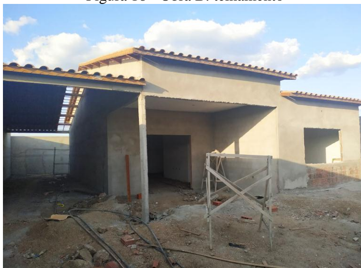
Figura 16 - Obra B: telhamento
