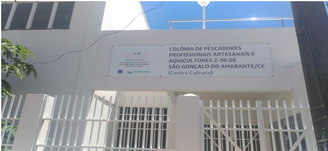
Figura 2 - Figura 2 - Prédio sede localizado no Distrito do Pecém, da Colônia de Pescadores Z-06 de São Gonçalo do Amarante.
