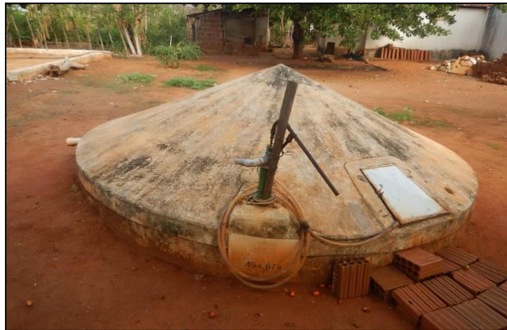
FFigura 91 - Cisterna de placa: principal sistema de armazenamento de água na zona rural. Fonte: acervo da pesquisa (2018)
