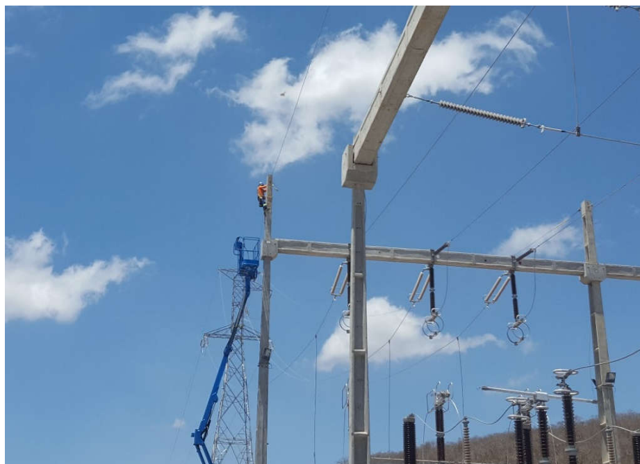
Figura 32 - Segregação dos cabos guarda da linha de transmissão com a subestação.
