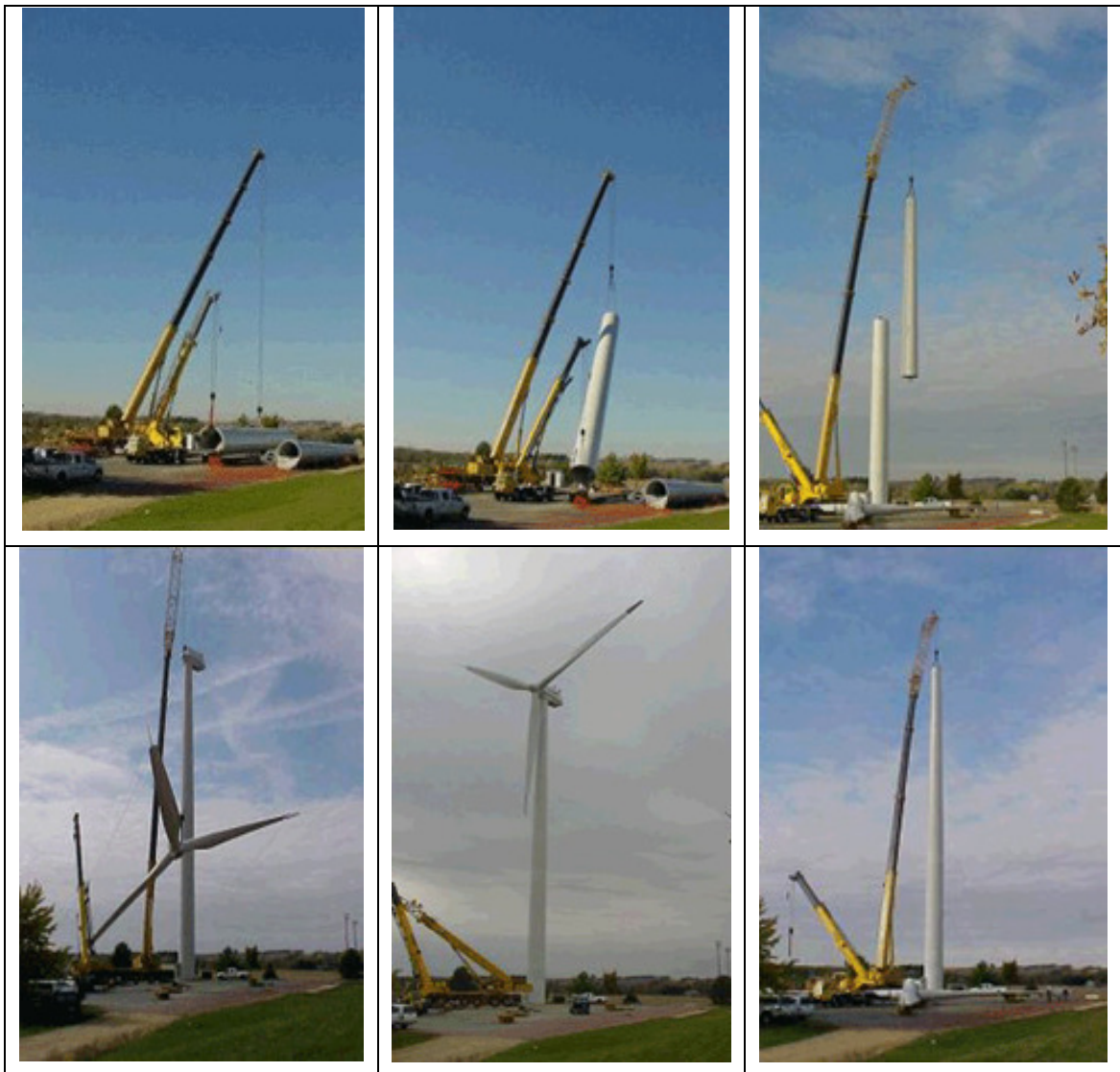
Figura 7 – Montagem de uma torre eólica tubular (VIEIRA, 2010)
