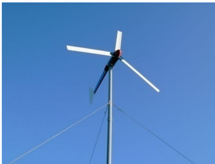
Figura 9 – Torre eólica estaiada (GARY, 2010)
