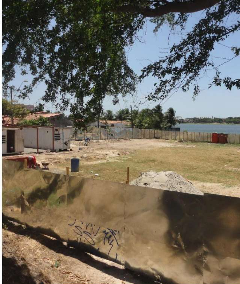
Imagem 92: Obra do arezinha em execução, próximo ao Ginásio. Fonte: Autora.
