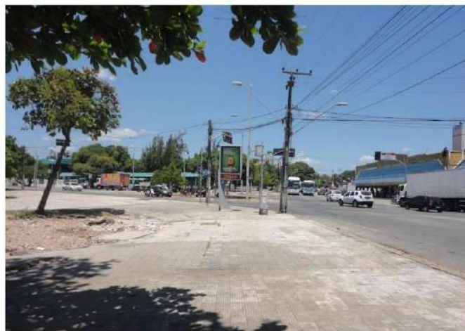
Imagem 83: Terminal da Lagoa, inaugurado em 1993. Fonte: Autora.
