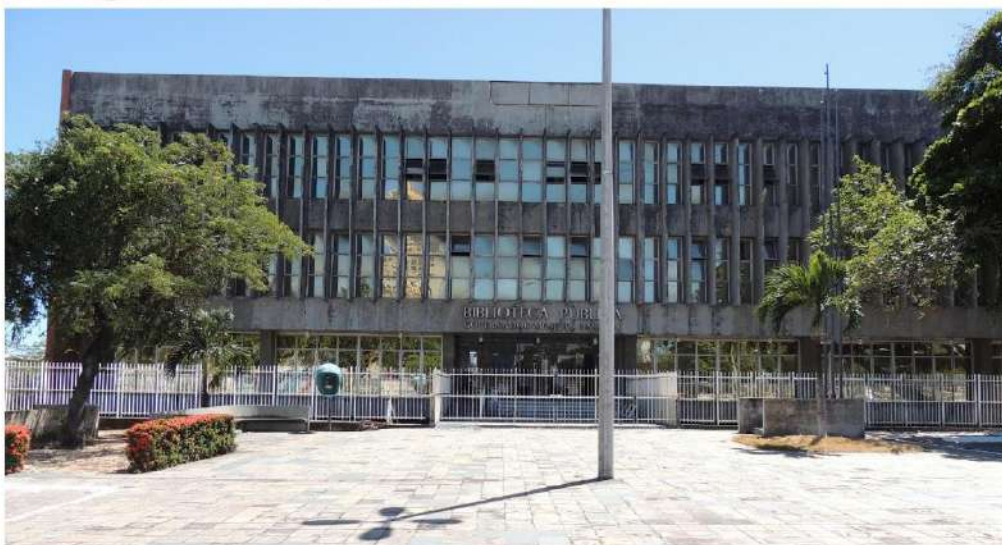
Imagem 25: Fachada Sul da Biblioteca Menezes Pimentel. Fonte: Acervo do LoCAU.
